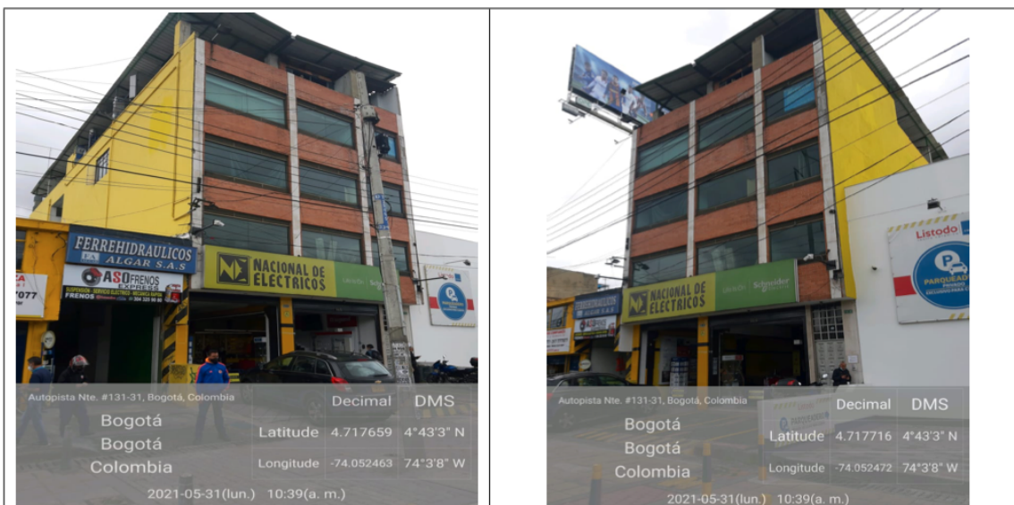
Foto panorámica del establecimiento 31/05/2021
